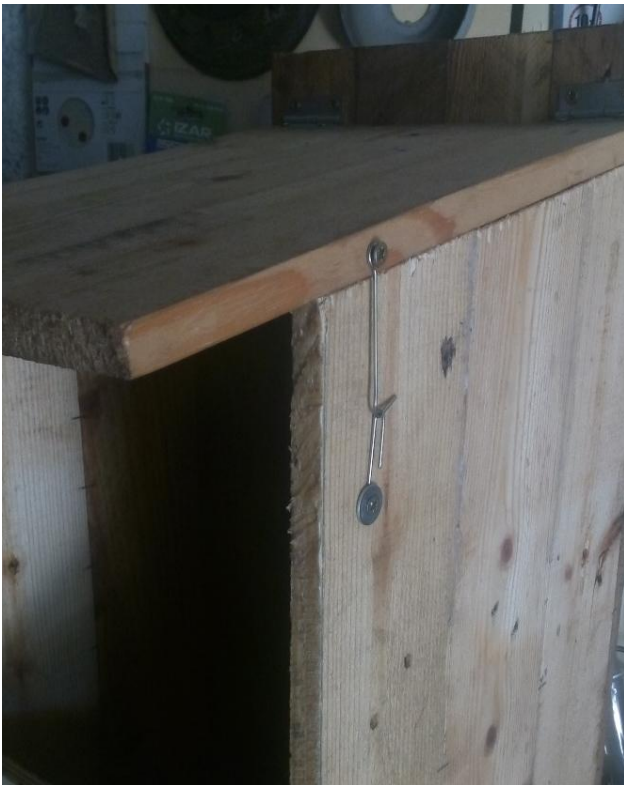
Detalle de las aldabillas que bolquean el tejado. Foto: Fernando Calderón.
